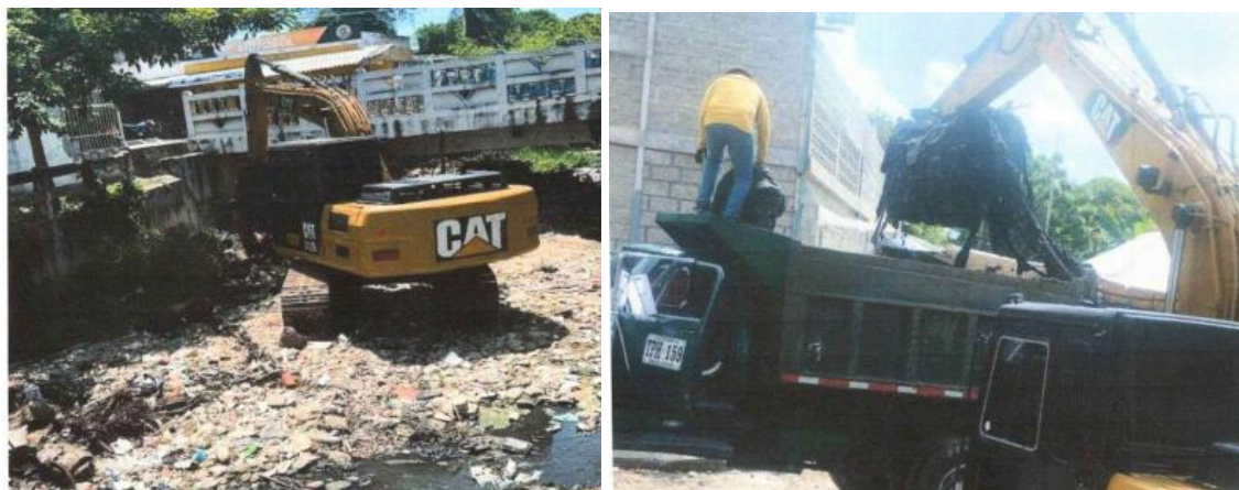
Ilustración 6 Intervención del Tramo del arroyo Paso el Libertador.
