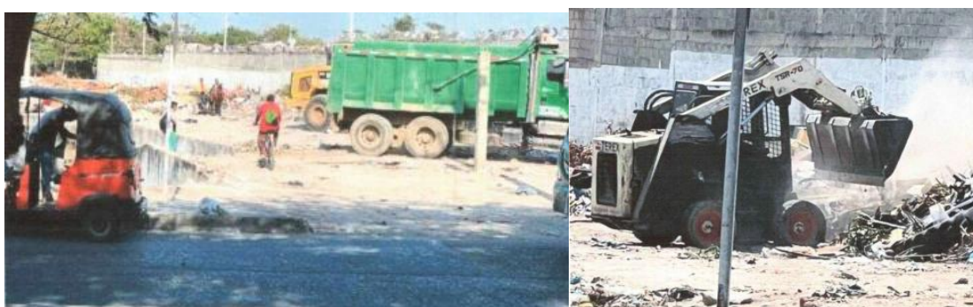
Ilustración 3 Intervención del Tramo del arroyo el Salao Barrio Salamanca.
