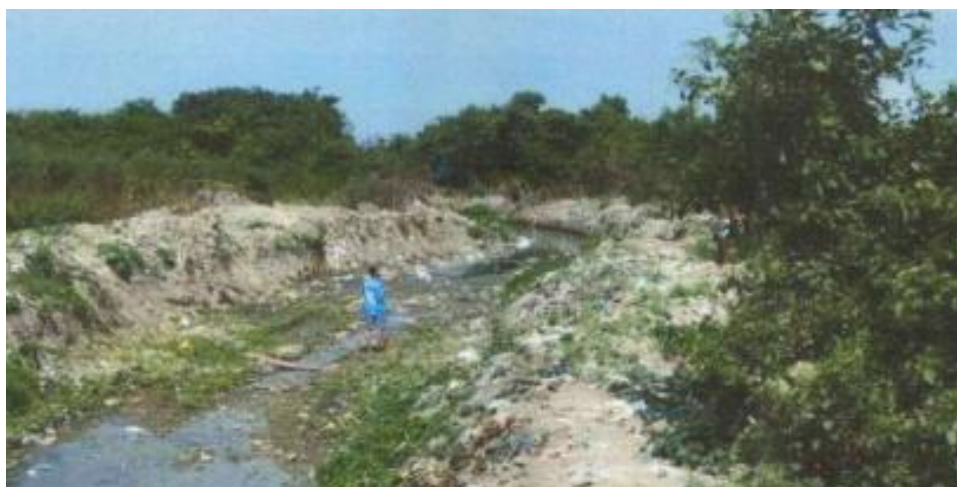
Ilustración 10 Estado inicial del Tramo del arroyo Cachimbero
